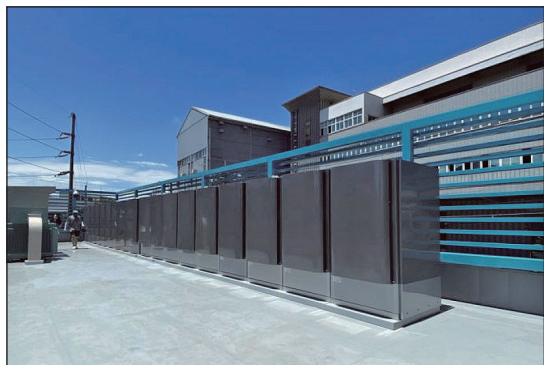
圖 3 欣興電子建立台灣第一座氫燃料電池廠（600 kW）使用 2 × 325 kW Bloom Energy Server
