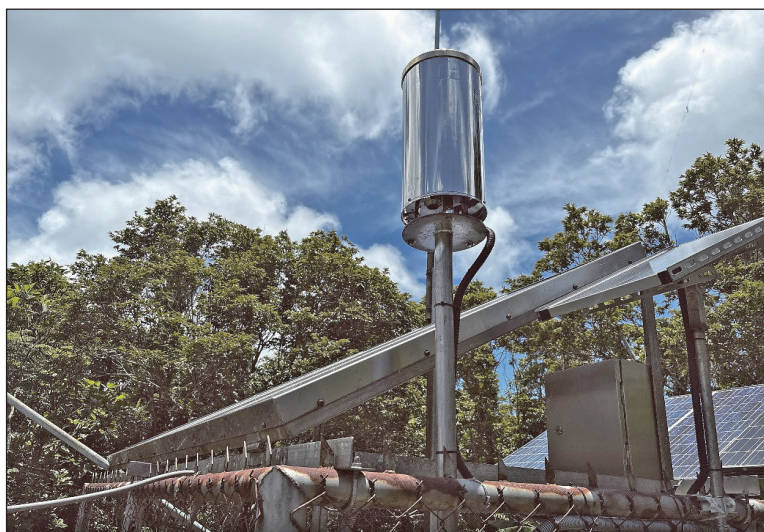
圖 1 牡丹水庫集水區雨量監測站
