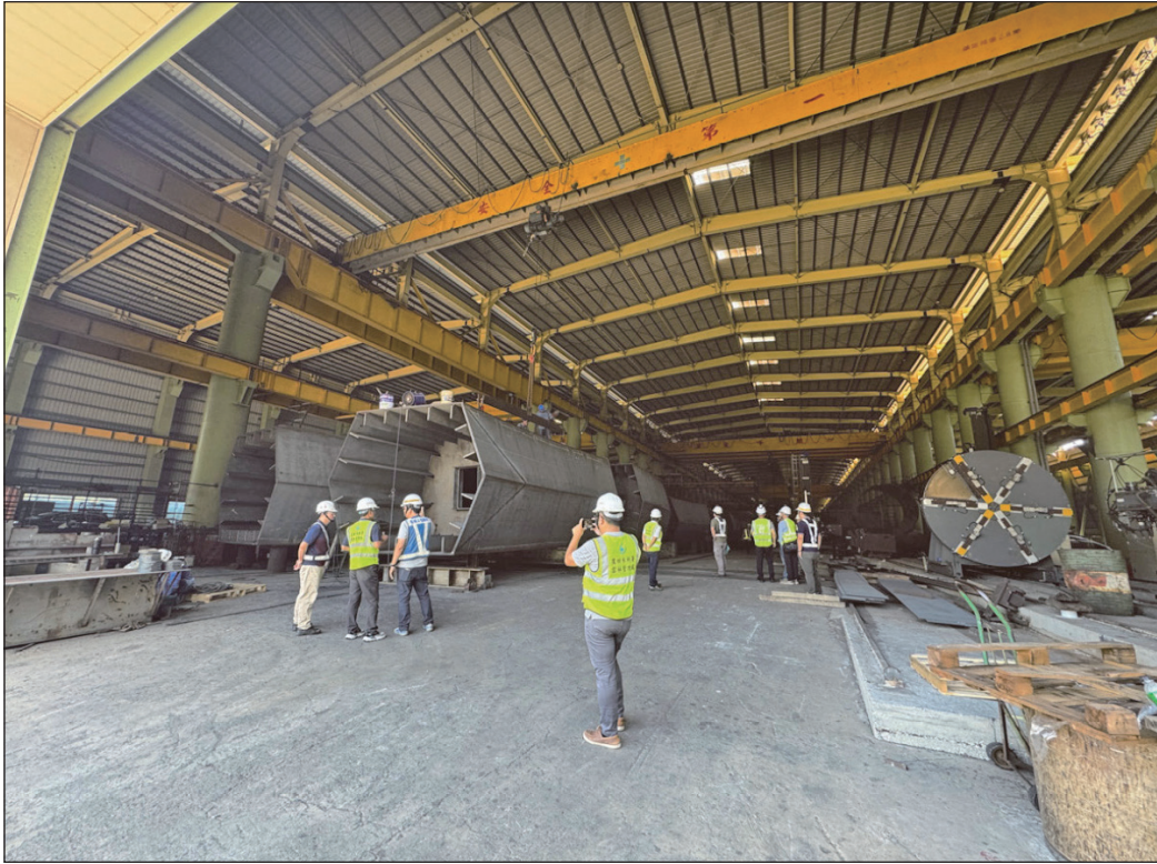
圖 10 渡槽塔柱鋼構廠組裝
