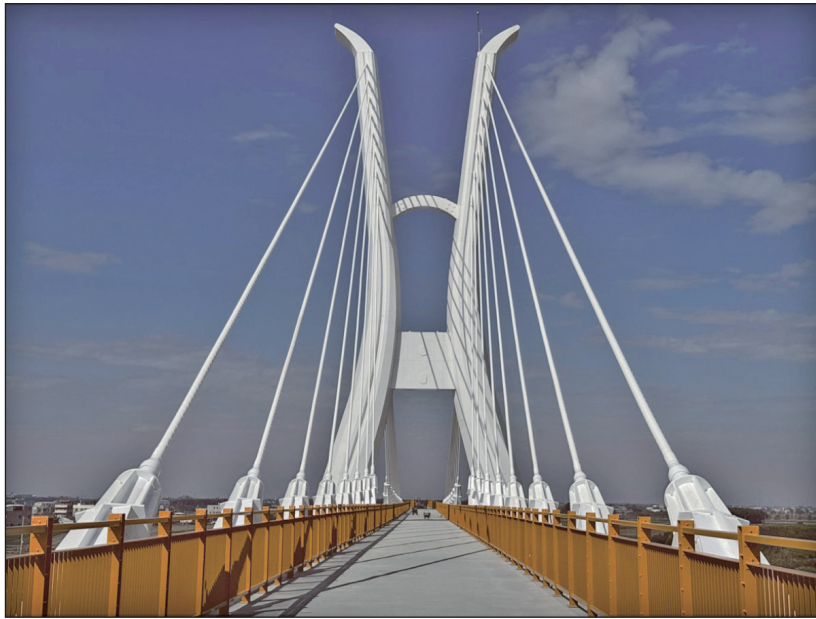
圖 3 渡槽塔柱造型完成照片
