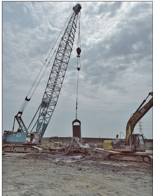
圖 4 基礎施工照片
