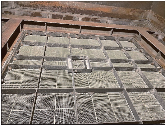
圖 3 選擇性觸媒還原反應塔 (SCR)
