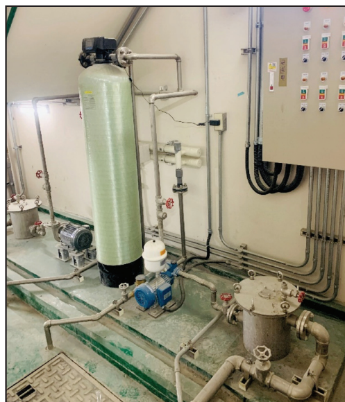
圖 6 雨水回收過濾桶 / 紫外線殺菌器
