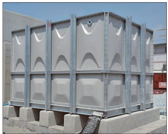
圖 8 南科再生水廠連續反洗式重力砂濾槽（左圖）及組合式 FRP 水槽（右圖）
