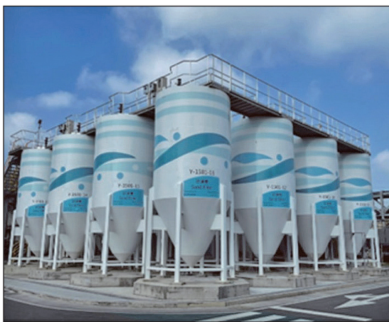
圖 8 南科再生水廠連續反洗式重力砂濾槽（左圖）及組合式 FRP 水槽（右圖）
