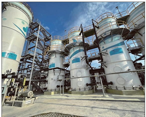
圖 4 南科再生水廠應用之生物處理程序（BioNET，左圖）和化學處理程序（FBC，右圖）
