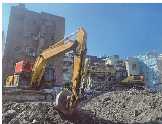
圖 6 舊建物拆除分類回收（左）及再生混凝土澆置（右）
