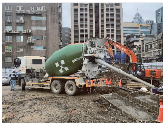
圖 6 舊建物拆除分類回收（左）及再生混凝土澆置（右）
