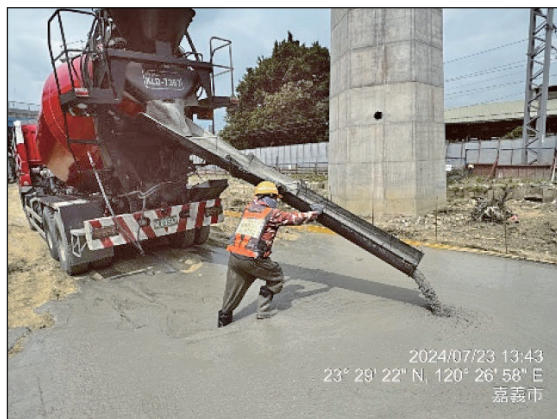
圖 5 推動全國第一座科技廠房（左）及公共工程（右）使用 PLC 低碳混凝土
