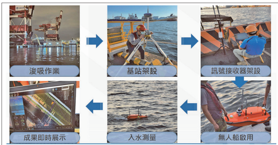
圖 4 無人船進行碼頭水域深度量測流程
