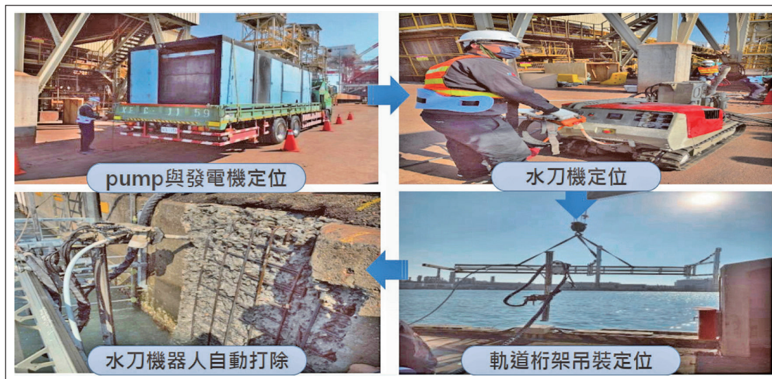
圖 5 碼頭水刀機器人安裝流程
