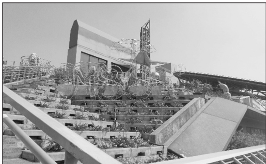
圖4 孫運璿綠建築研究大樓上的浮力通風塔促進上下自然通風，是節省能耗的一大助力
