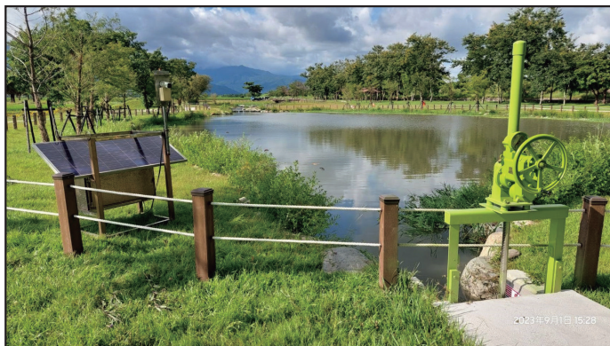
圖 15 引水渠道起點設置太陽能即時影像監視系統
