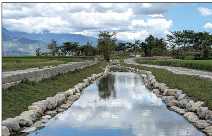
圖 13 渠道以無水泥封底設計
