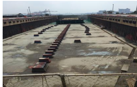
船舶維修基地 (10000噸船塢設備)
