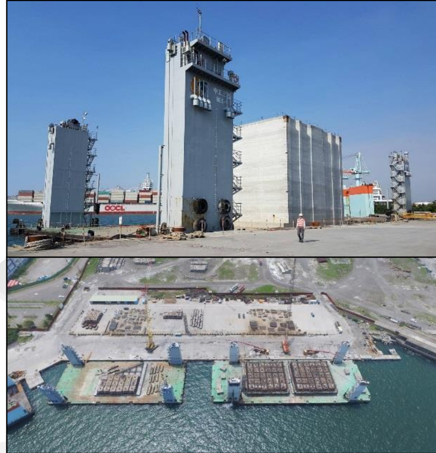
外廓堤工程浮船台工法實景
