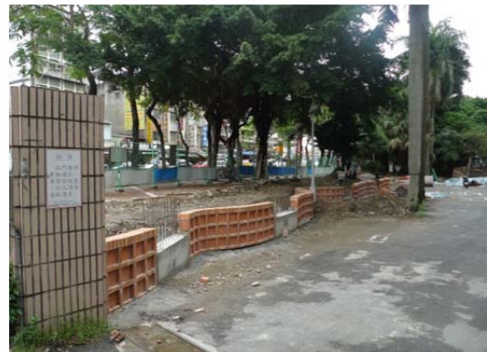
八德路沿街水景與工專橋復舊 (施工中)
