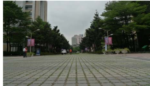
改善為具有結構支承力之透水鋪面
