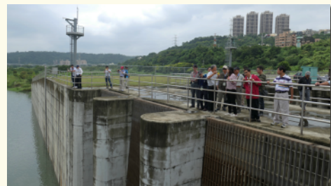
全員至中庄調整池引水口聽取作業介紹。
