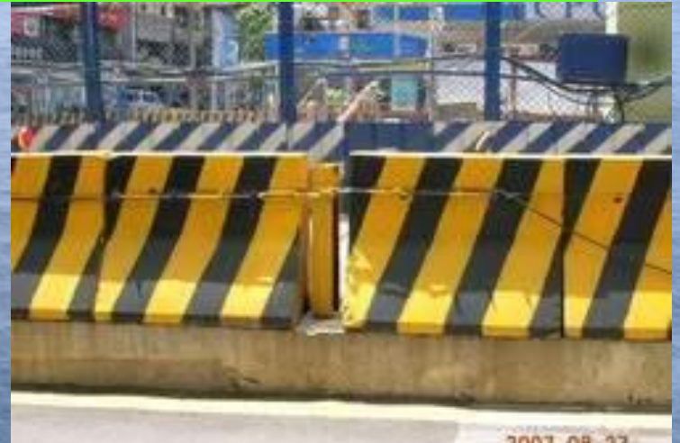
H型鋼固定護欄
