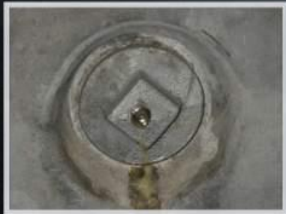
一般常用之化學藥劑止漏處理
