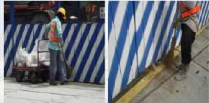
進行工區圍籬底部垃圾及沉泥清掃
