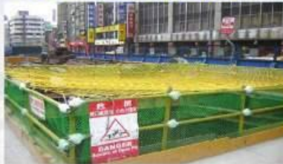
投入口使用制式安全防護棚及H200型鋼(連結固定及做為腳踏板使用)
