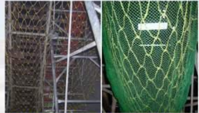
重型施工架下方鋪設安全防護網確保施工安全(長5M寬1.5M)
