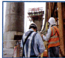
1. 工作車推進及調模定位與檢測
