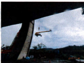
➤高空作業車吊至橋面
