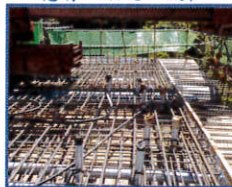
3. 頂板鋼筋及套管安裝
