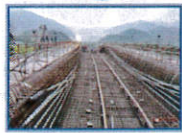
3. 預力套管安裝及穿線
