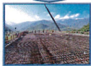
5. 頂版鋼筋綁紮
