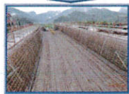
2. 底、腹版鋼筋綁紮
