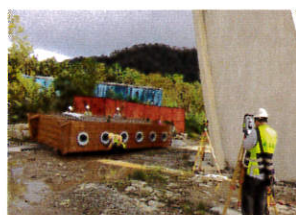
➤外置斜索端錨安裝
