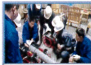
2. HDPE外套管焊接
