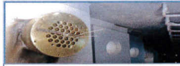
3. 固定端錨檢查及安裝
