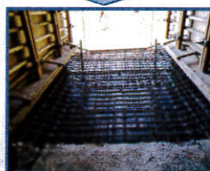
2. 底板鋼筋綁紮
