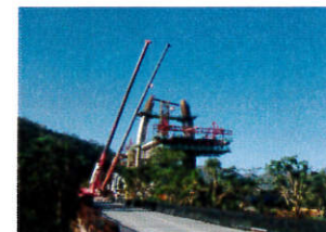
➤鋼箱橫向支撐安裝
