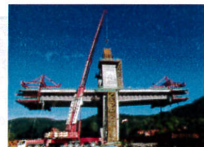
➤鋼箱起吊橋塔
