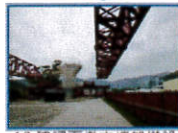
12. 確認下墩支撐架措施是否完成
