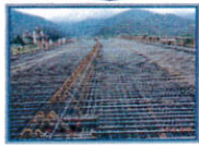
6. 混凝土澆置前置作業
