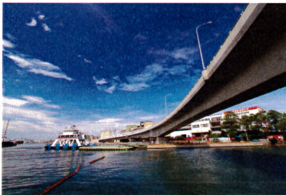
前鎮河護岸新建工程完工實景
