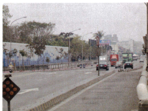
新生路北段施工前照片(面向旗津方向)
