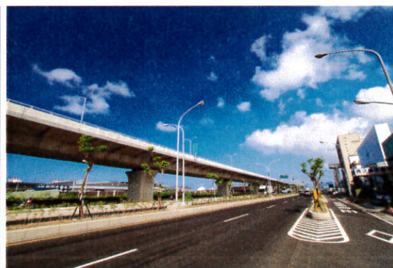
新生路北段完工後照片(面向市區方向)
