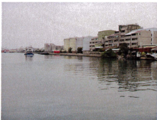
前鎮河護岸施工前(自前鎮橋遠眺)
