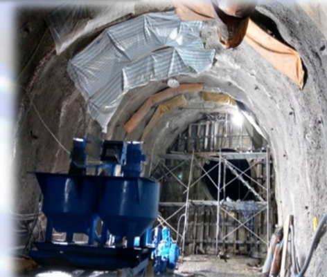
混凝土回填澆置
