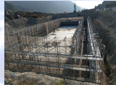
調整池鋼筋綁紮
