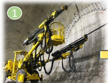
先撐鋼管支撐及開挖
