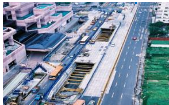
■台北信義線CR283施工 標R06車站與橫渡線工程 暨上方共同管道工程
