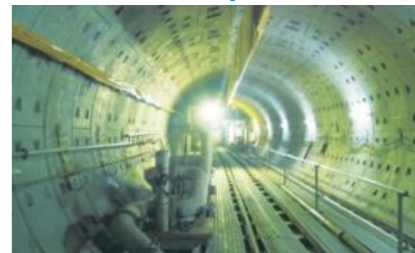
■台北新莊線CK570C/G/E 區段標工程
