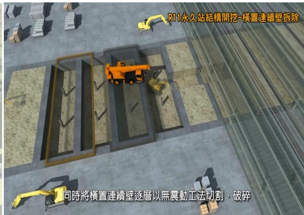
R11永久站橫置連續壁拆除(廠商提供)
