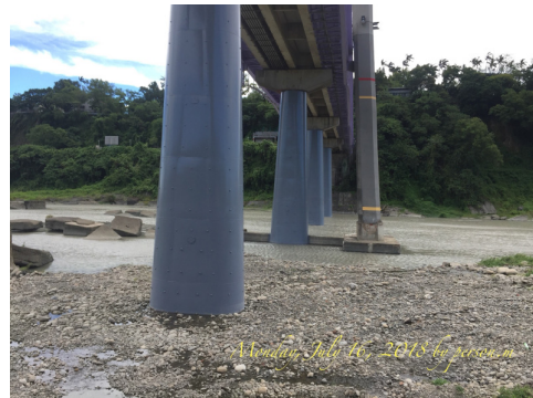
(D) 2 代橋-橋墩鋼板包覆補強
