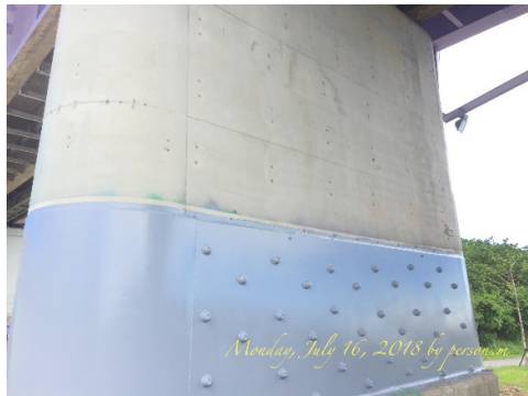
(C) 1 代橋-橋墩 RC 包覆補強
