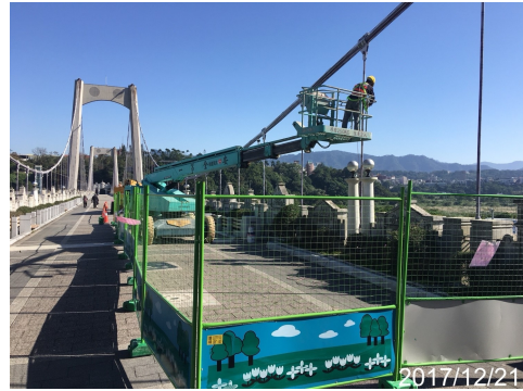
(B) 高空作業及交通維持設施
