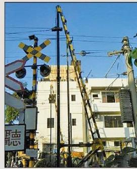
圖12 升降式遮斷機及警車裝置
