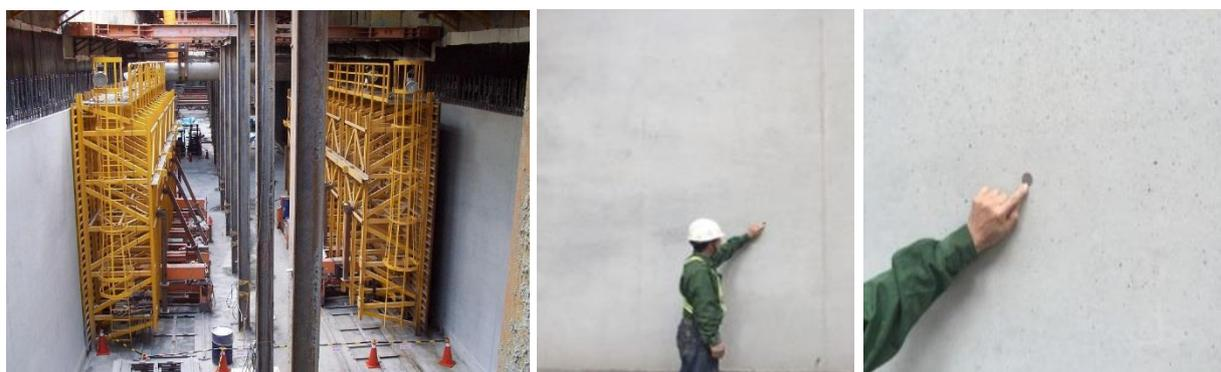
圖 13 自動化模板結構體澆置後表面平整度
