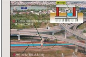
圖33 大橋中斷架橋橋墩與左側計畫之巨鑽鑽孔引致裂開位置
