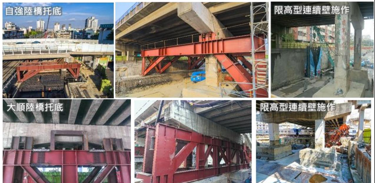
圖 10 陸橋托底施工現況
