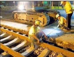
圖16 軌道定位鋪設
