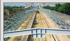
圖35 臨時月台鋼構吊裝外觀
