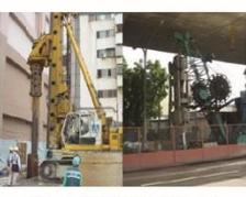
圖 11 限高連續壁及全套管切切牆
