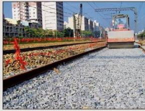
圖6 碎石底層鋪設滾壓
