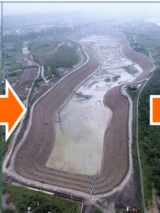
106/3/31圍堤主體完成
