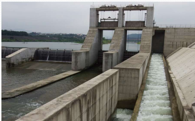
魚道水流情形，流況符合本河段魚類
