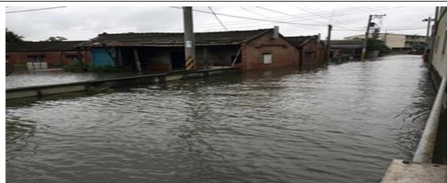
大埤鄉西鎮村汪洋一片
