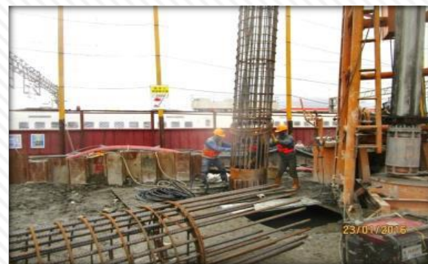
採用鋼套環搭接
