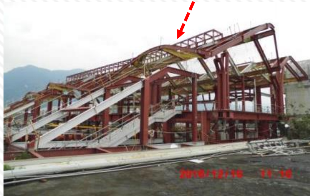
自由通道月台段 鋼構構件焊接、螺栓鎖固
