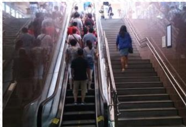
電扶梯 / 花蓮車站
