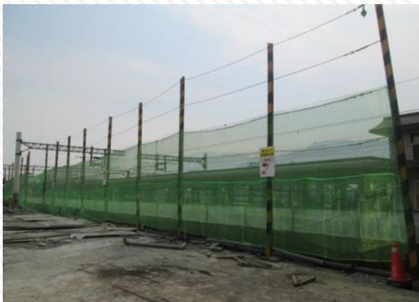
鄰軌側設置鋼軌防護樁及防護網
