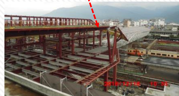
自由通道月台段 鋼構構件焊接、螺栓鎖固
