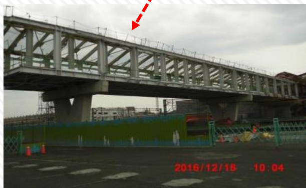
自由通道橋梁段 橋面板完成
