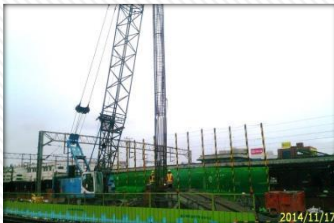
P2、P3墩柱基樁全套管基樁施工
