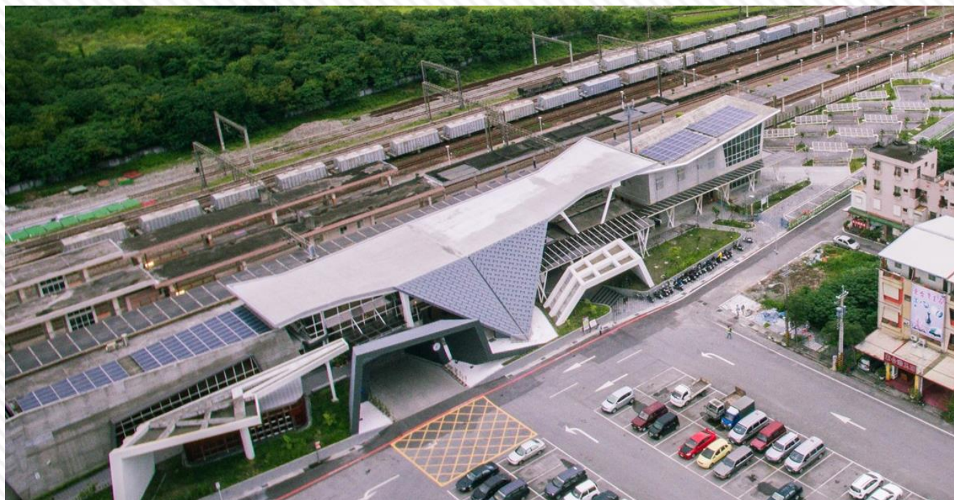
綠建築黃金級車站 / 新城車站
