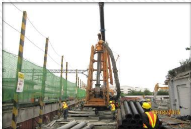
第一月台基樁配合主體先行施作
