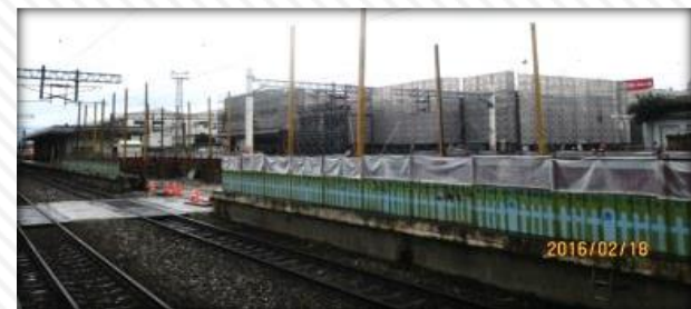
第二、三月台設置防護鋼軌
