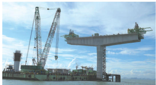
▲ 金門大橋施工情形
