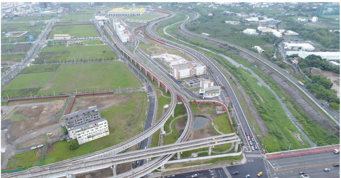
▲ 臺中捷運線機廠
