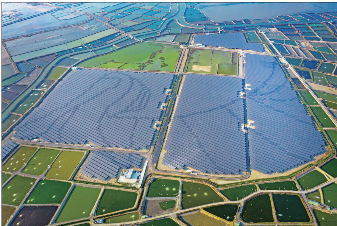
圖 1 韋能能源嘉義義竹電廠，是台灣第一座擁有生態保留區的民營太陽能電廠。
