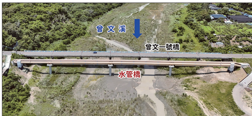
圖 16 完工後之水管橋
