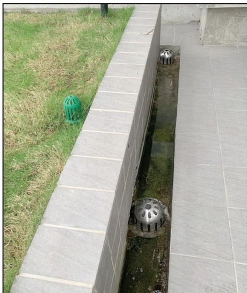
圖 4 屋頂雨水溝及落水頭雨水收集濾設備
