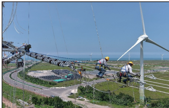
圖 9 導線更換施工
