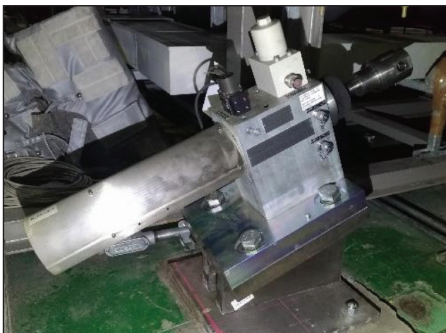
圖 36 更新之進氣導翼驅動器
