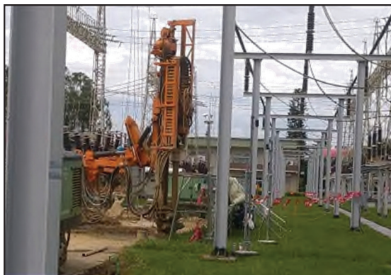
圖 61 山上一次變電所匯流排及終端設備增設工程採用圓型樁工法施工
