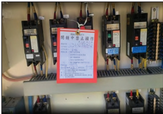
圖 64 LCC 開關箱關鍵管制點懸掛管制卡
