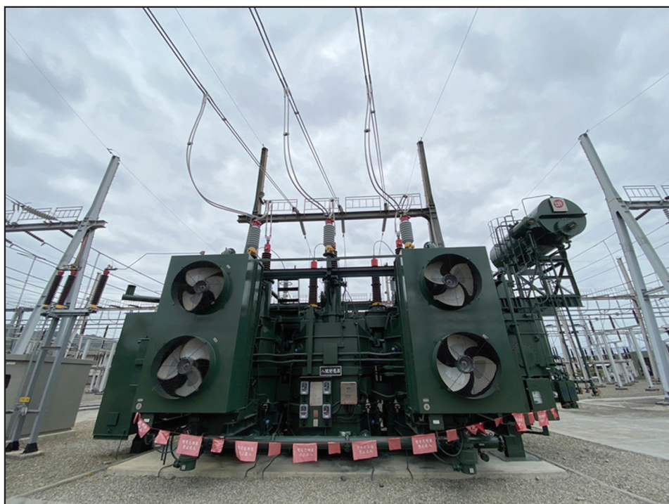
圖 55 南投 E/S #8MTR 變壓器完工圖
