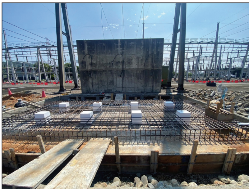
圖 53 變壓器基礎重建圖
