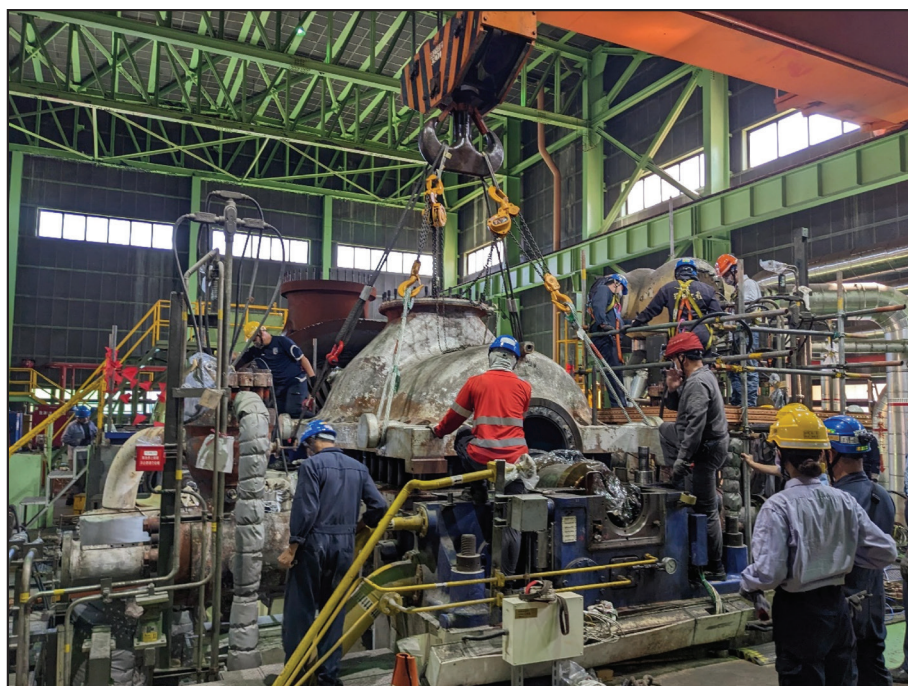
圖 32 高壓汽機外缸上半回裝
