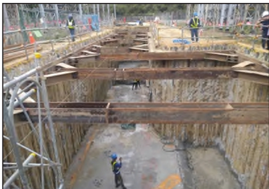
圖 62 山上一次變電所匯流排及終端設備增設工程土建施工
