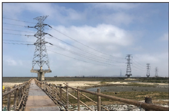
圖 10 工安考量設置通行棧橋
