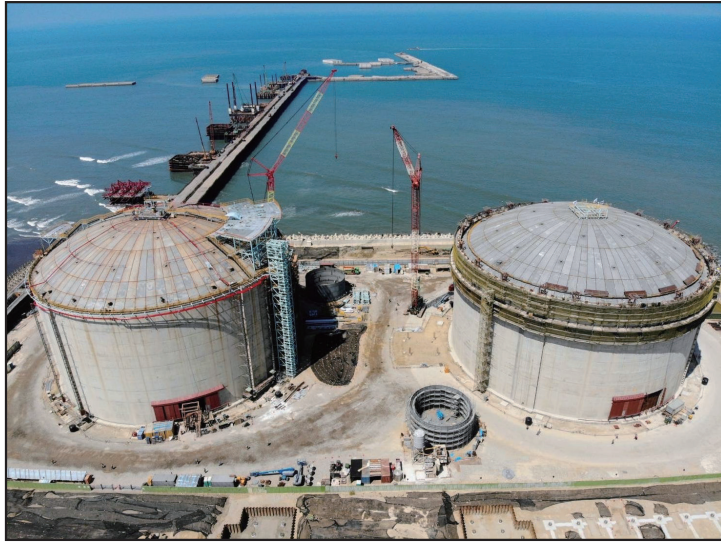
圖 7 第二座儲槽 (右邊) 屋頂吹浮升頂工程
