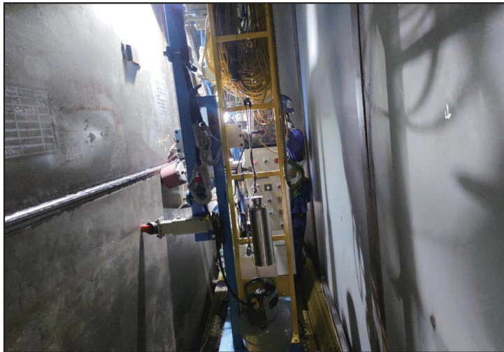
圖 8 儲槽夾層特製自動化潛弧銲接機
