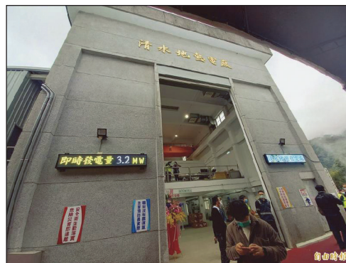
(b) 即時發電量 3.2 MW
