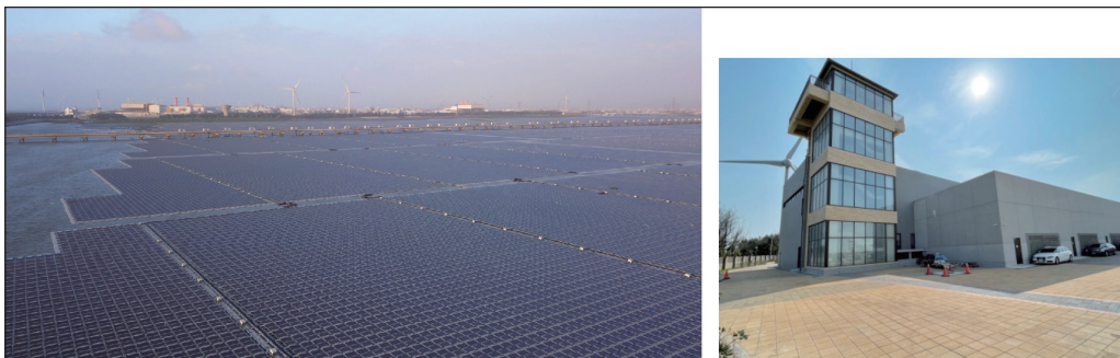
圖 13 彰濱崙尾東一號暨二號電廠是臺灣首座建置於近海區域的水面型太陽光電電廠
