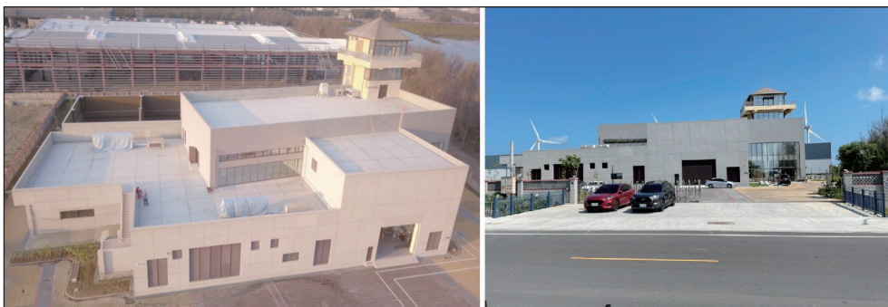
圖 10 161 kV 自設變電站外型
