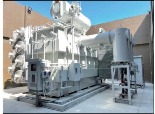
圖 8 主變壓器
