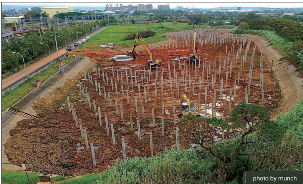
圖 28 基樁型施工示意圖
