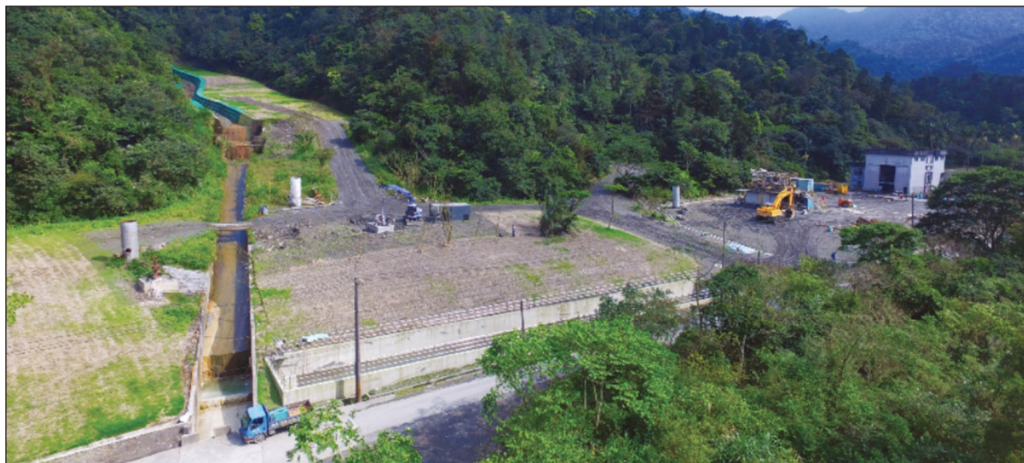
圖 11 水保工程施工概況
