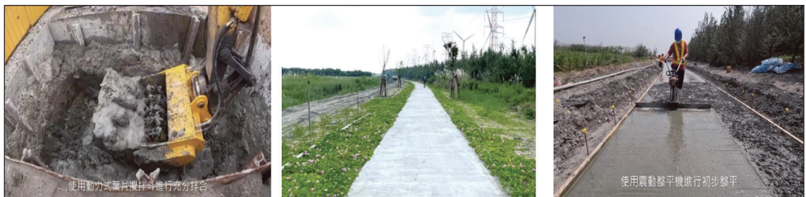
圖 8 固化土步道施作情形
