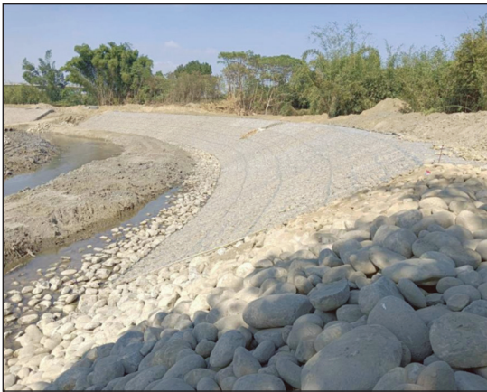
圖 9 石籠取代坡面工
