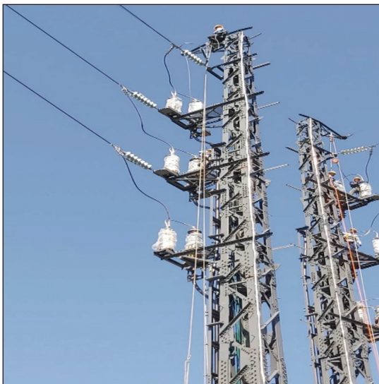
圖 24 線路改接作業
