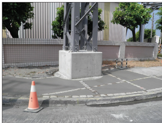
圖 46 工業區人行道之鐵柱
