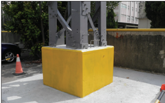
圖 47 力麗公司廠房圍牆內鐵柱
