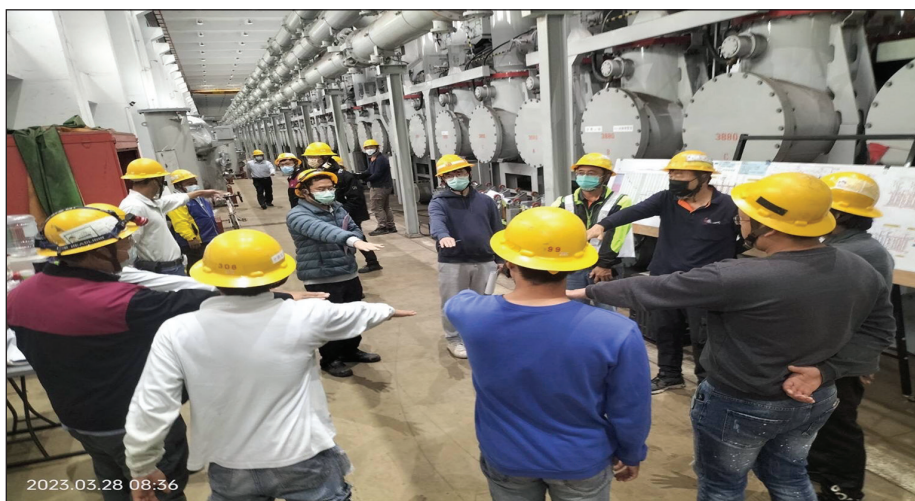
圖 1 開關場 GIS 設備汰換工程作業前 TBM
