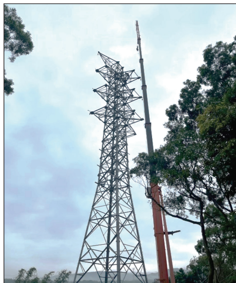
圖 22 鐵塔裝建（吊車法）
