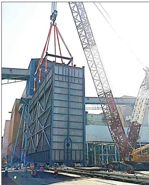
圖 7 濕式靜電集塵器吊裝作業
