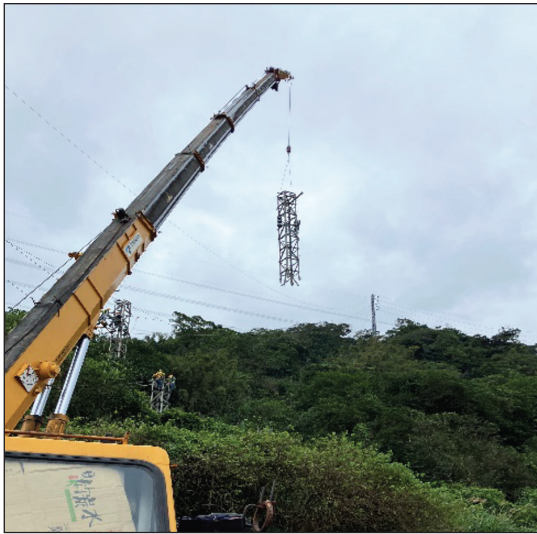
圖 23 舊桿塔拆除
