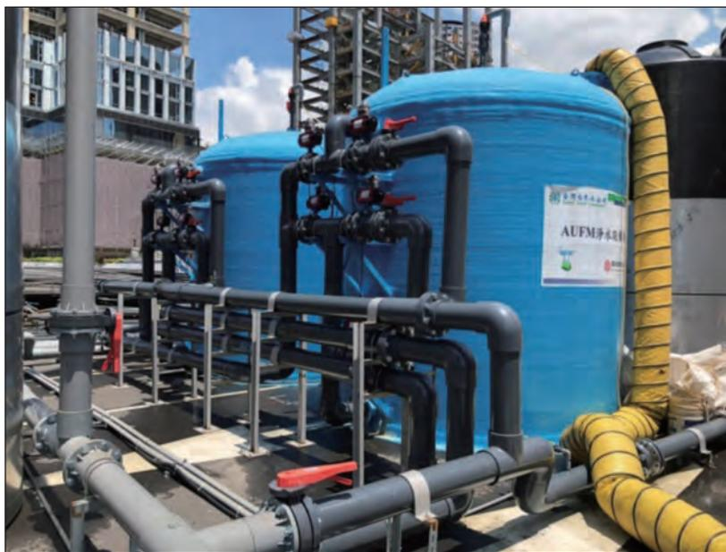
圖7 建築工地地下水利用情形
