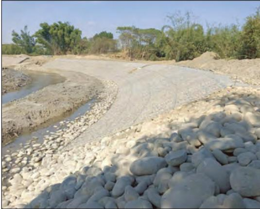
圖9 石籠取代坡面工
