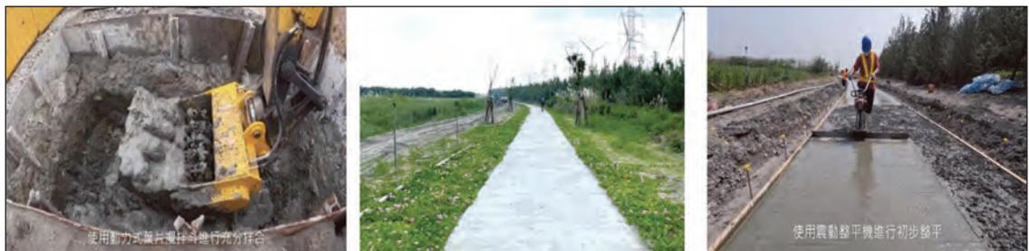
圖 8 固化土步道施作情形
