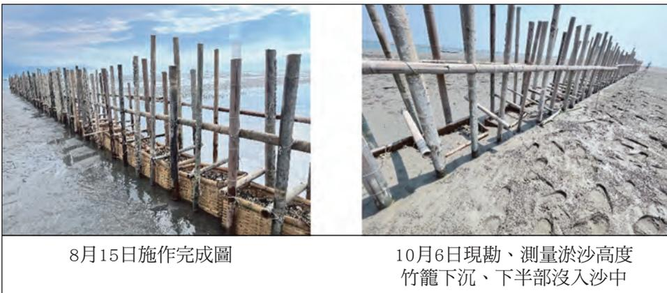
圖 9 竹籠固沙工攔沙成效
