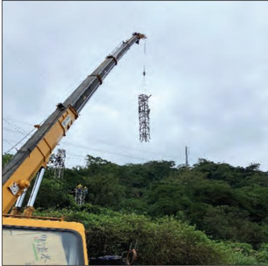
圖 23 舊桿塔拆除
