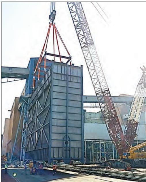
圖 7 濕式靜電集塵器吊裝作業
