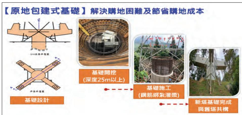
圖 28 原地包建式基礎示意圖
