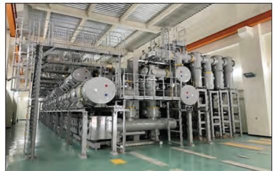
圖 13 345kV 氣體絕緣開關設備
