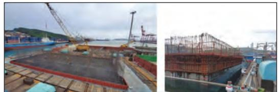
圖 9 基隆港 W28 碼頭之升降平台之施工安全防護設施照片
