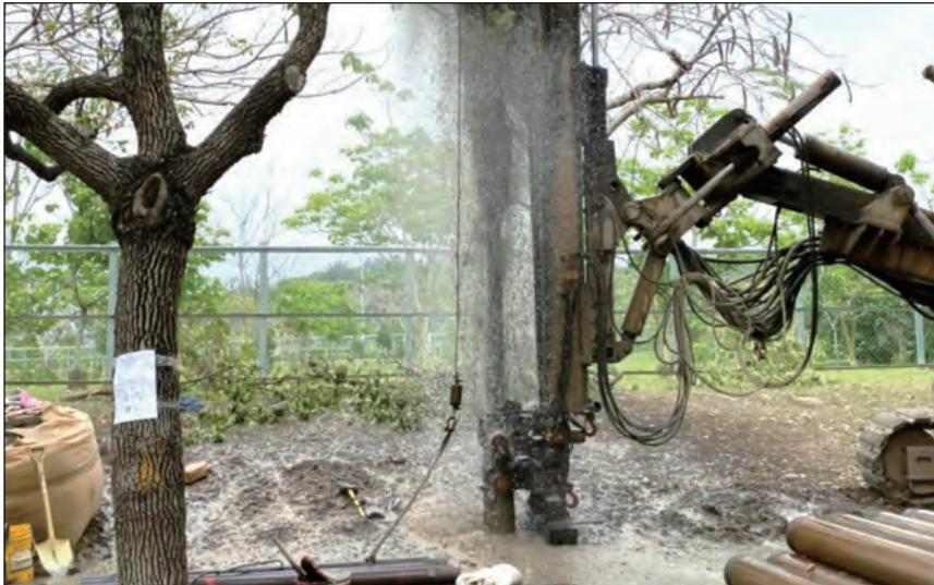
圖 4 抗旱水井施工情形
