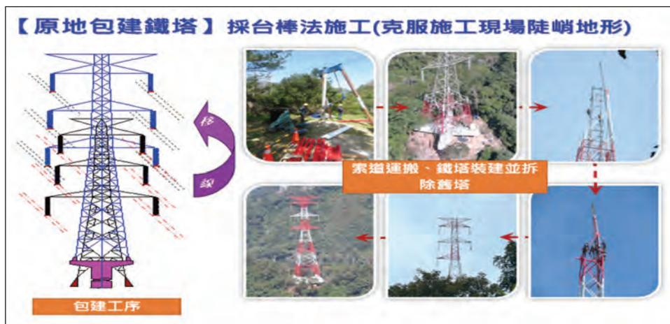
圖 29 原地包建鐵塔示意圖
