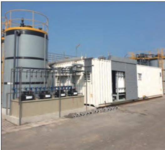
圖 13 RO 移動式淨水設備
