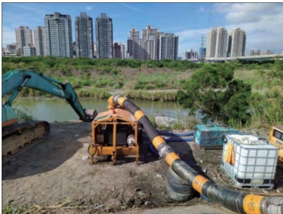
圖 16 隆恩堰下游緊急抽水情形
