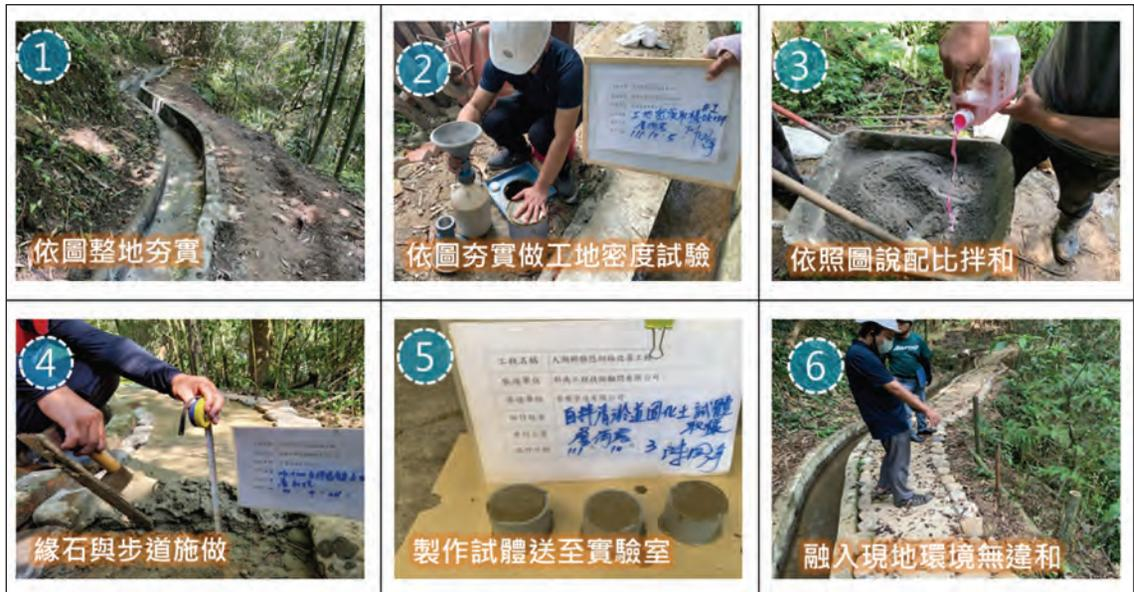
圖 6 自拌清淤道施工過程
