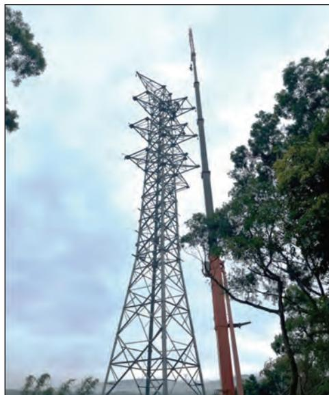
圖 22 鐵塔裝建（吊車法）
