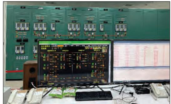
圖 12 控制室（IEC 61850 系統）
