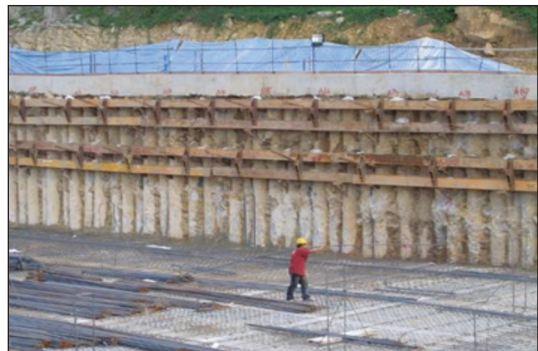
圖 18 預壘排樁施工現況
