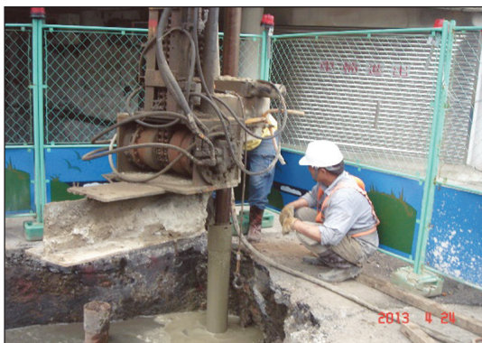
圖 19 鄰近建築旁施作微型樁現況照
