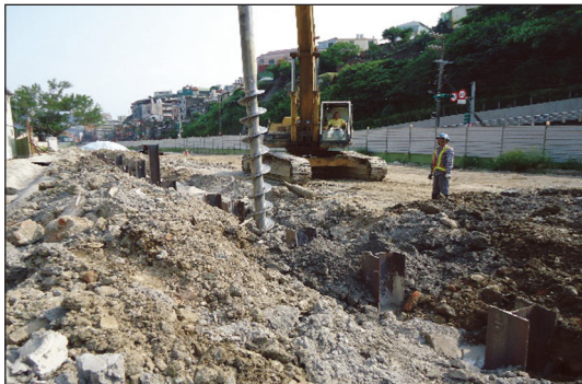
圖 17 舊橋基礎預鑽引孔植入鋼板樁現況
