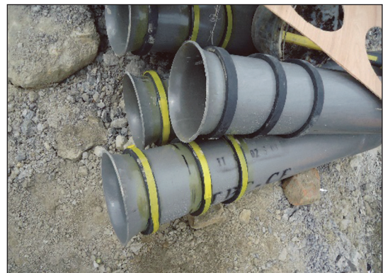
圖 23 預埋過牆管施工示意圖
