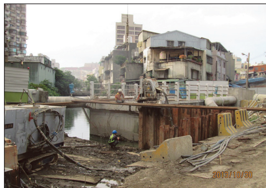
圖 20 海砂屋旁採靜壓工法施作臨時擋土
