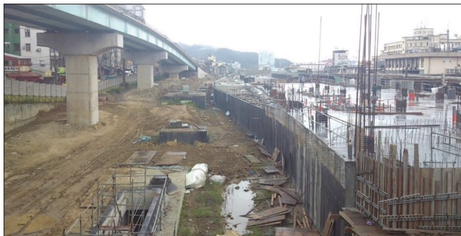
圖 6 新建港西高架道路 & 共同管道與基隆火車站新站工程共同施工現況
