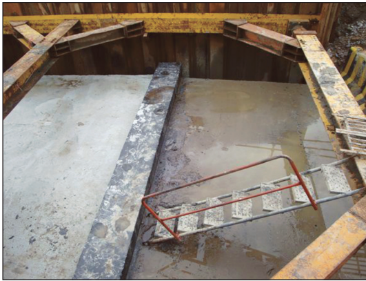
圖 24 管道段落間設計壓梁
