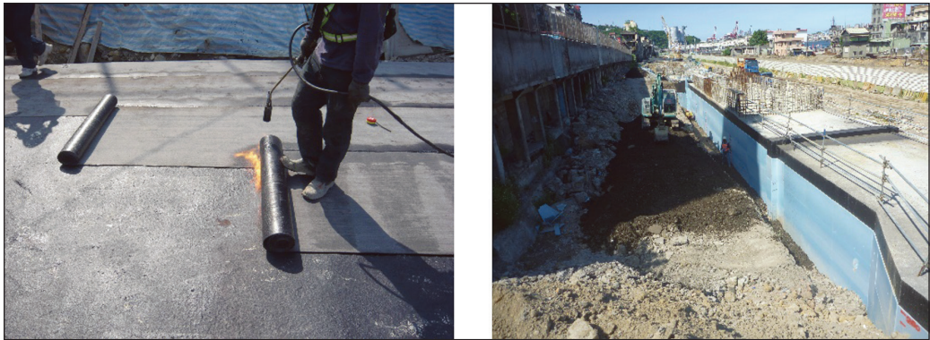
圖 21 幹管防水膜施做現況
