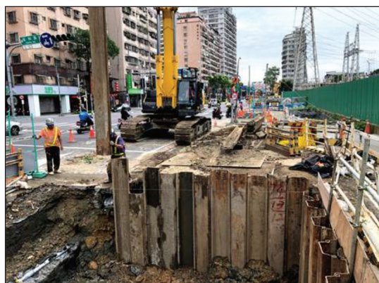
圖 22 板橋 ~ 景星紅白線 L 型涵洞
