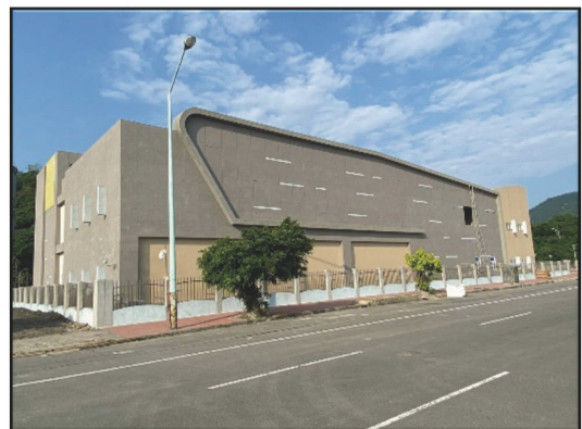
圖 1 屋內式變電所
