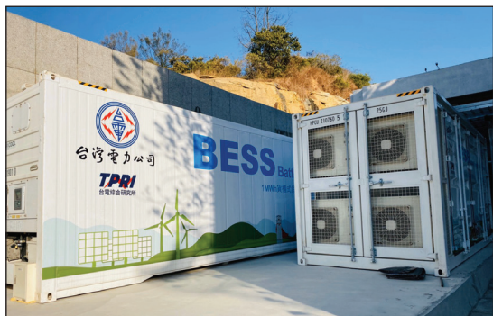
圖 14 鋰電池儲能系統
