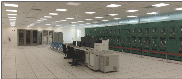
圖 5 控制室 (IEC 61850 系統)
