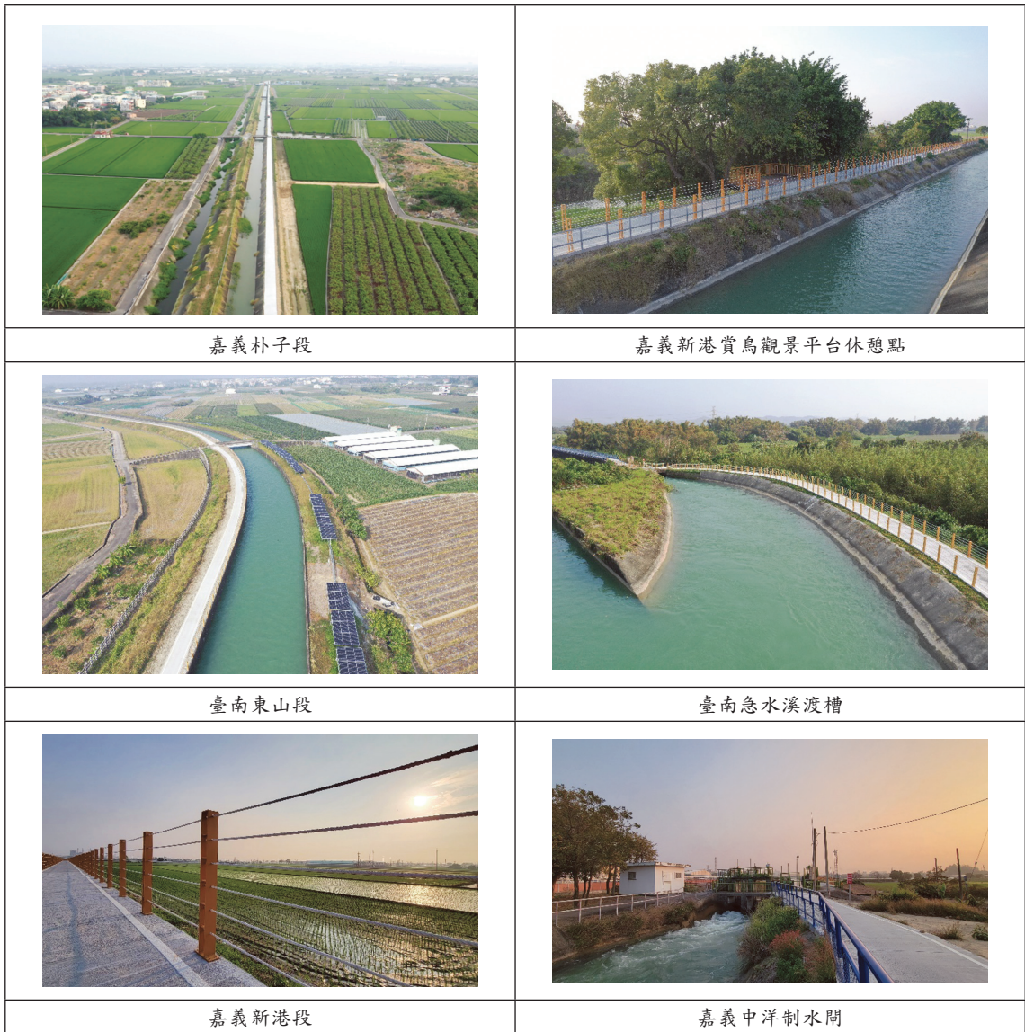
圖 10 水圳線道沿線路段、水利構造物及休憩區
