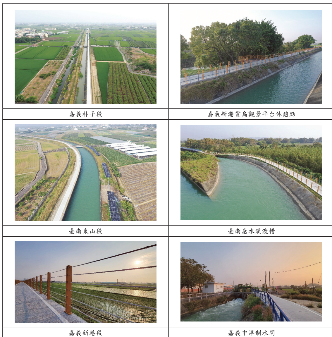
圖 10 水圳綠道沿線路段、水利構造物及休憩區
