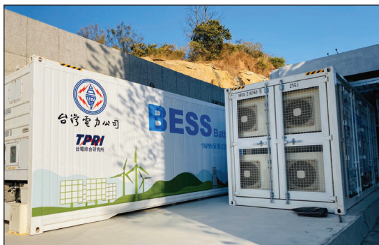
圖 14 鋰電池儲能系統
