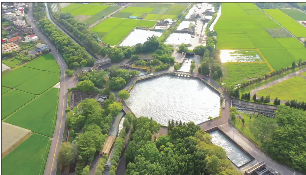
圖 2 水圳綠道終點八卦池分水工
