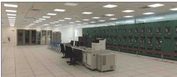
圖 5 控制室（IEC 61850 系統）
