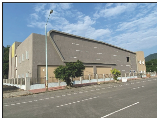
圖1 屋內式變電所
