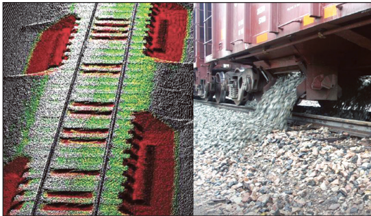
圖 30 智慧化補碴作業 [4]
