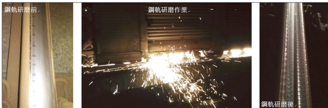
圖 18 鋼軌研磨作業 [11]
