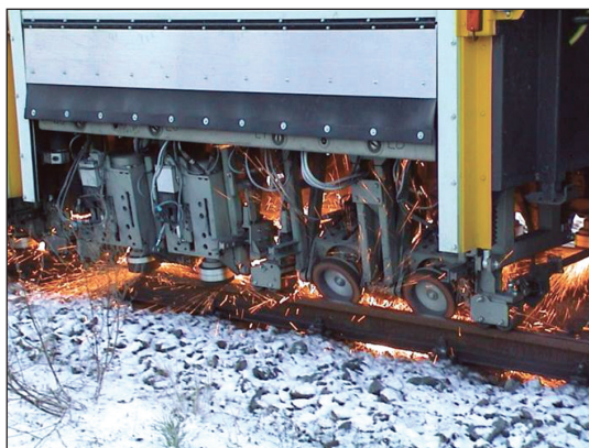
圖 17 研磨中的研磨模組 [10]
