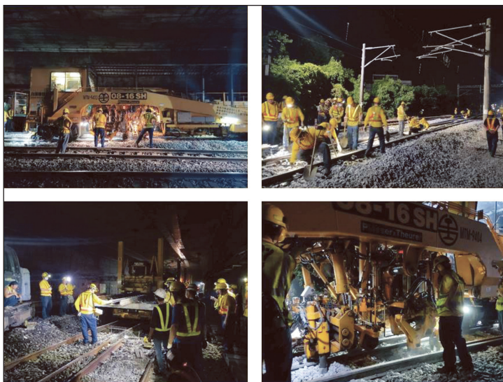
圖 4 臺鐵局養路作業實況
