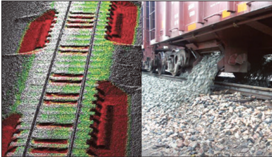
圖 30 智慧化補碴作業 [4]
