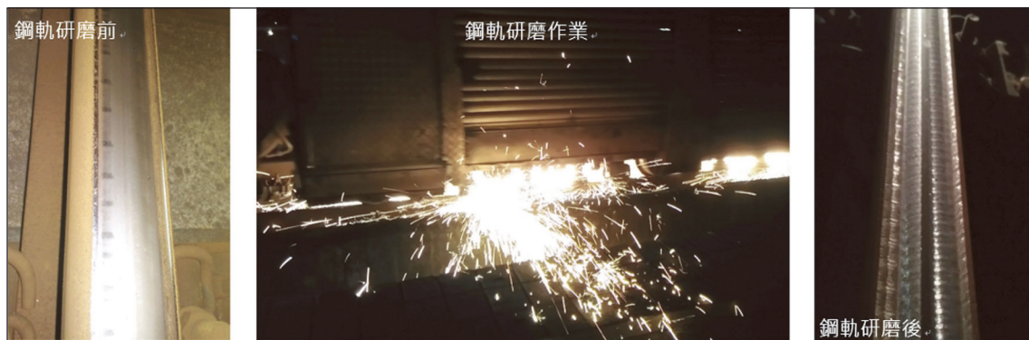
圖 18 鋼軌研磨作業 [11]
