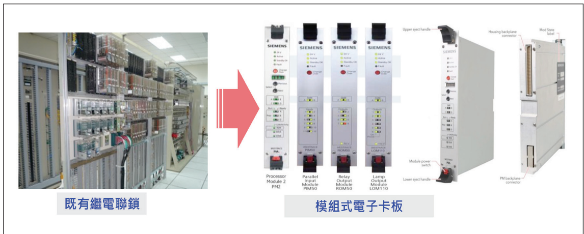
圖 4 號誌繼電聯鎖裝置更新為電子聯鎖裝置
