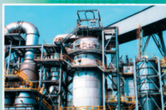
空氣污染防治系統 Air Pollution Control System
