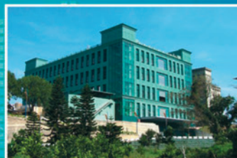
生技廠工程 Biopharmaceutical Plant
