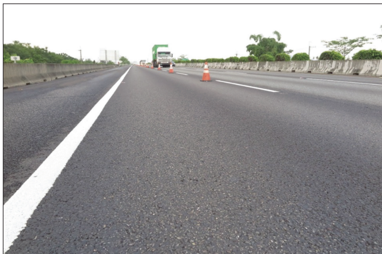
圖5 國道一號岡山段改質轉爐石多孔隙瀝青混凝土鋪設後照片
