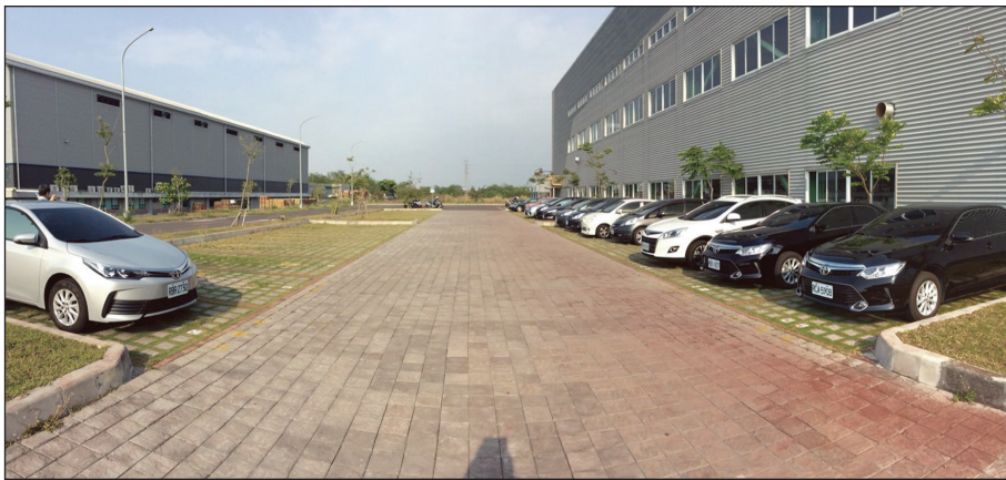
圖7 集團公司停車場鋪設之改質轉爐石高壓混凝土鋪面磚及植草磚
