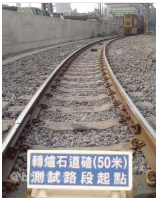
圖 10 改質轉爐石於中鋼廠區鐵路道碴之鋪設
