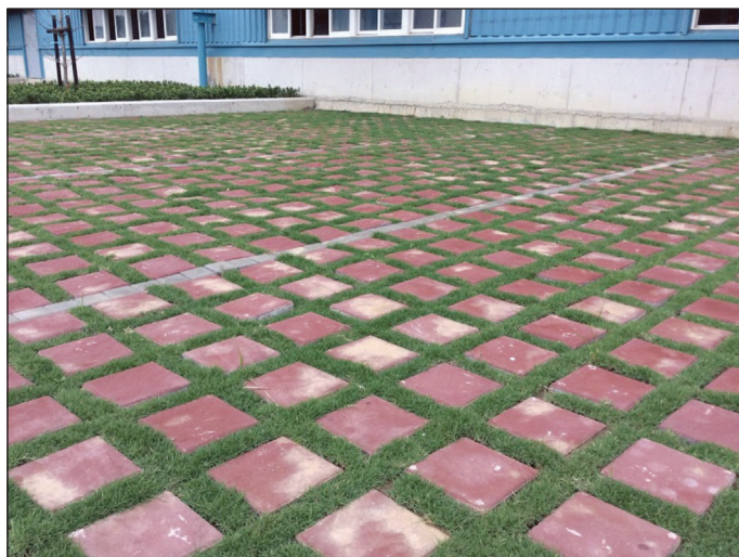
圖6 中鋼廠內鋪設之改質轉爐石高壓混凝土植草磚
