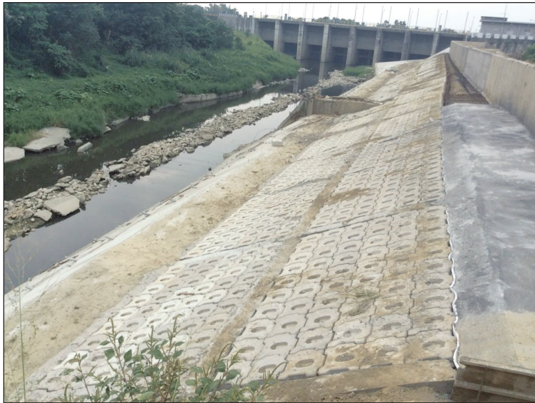
圖 8 鋪設於河岸之 2618 塊改質轉爐石護坡塊
