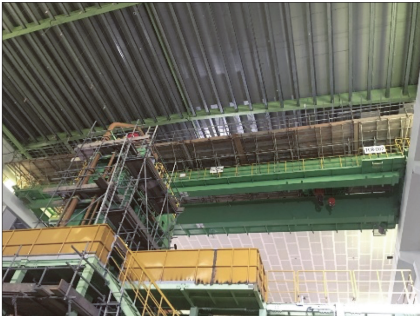
圖 5 天車搭架往返施作廠房大面積防靜電頂板
