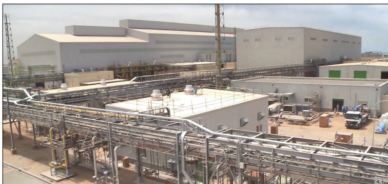
圖 9 海綿鈦廠完工實景
