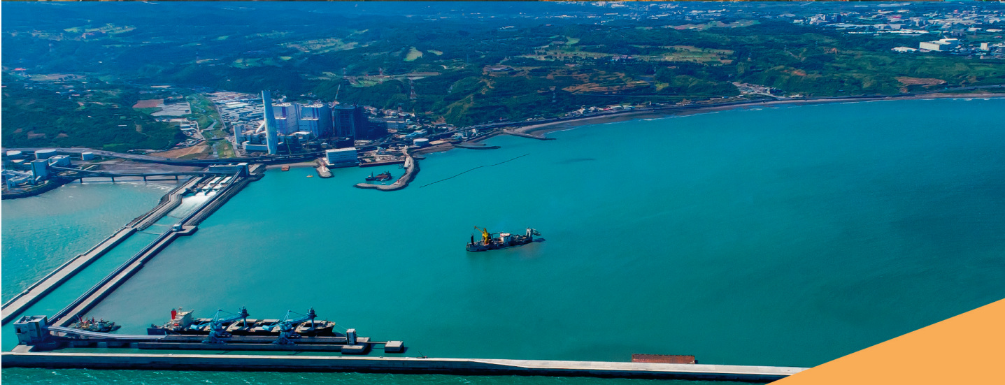
台中港106碼頭新建工程
