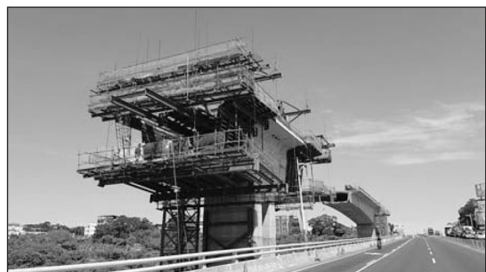
圖 11 地盤改良後順利施工之 p17 墩柱
