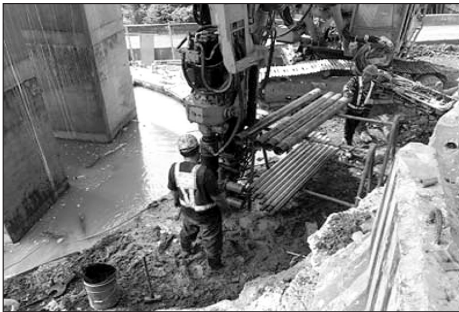
圖 8 地盤改良雙環塞灌漿施工
