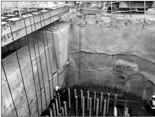
圖5 台電 161 kV 高壓電纜吊掛示意圖
