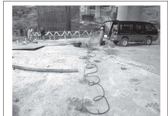
電阻試驗作業情形
