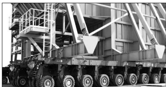
圖3 模組繫固於SPMT之實際情況(左前鋼構上)
