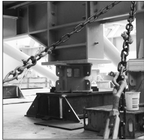
圖 18 模組下方之格床支承實況
