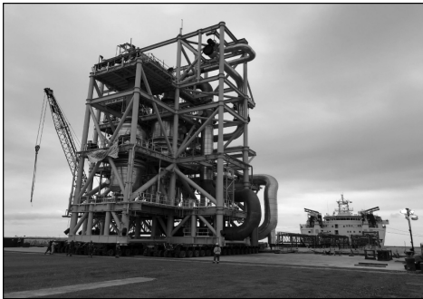
圖 6 模組藉由 RORO 方式裝貨上船（模組介於碼頭與重件船之介面中間，底下為 Ramp）
