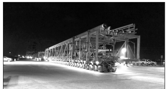
圖 17 管架模組於夜間在 HHR 道路運輸實況
