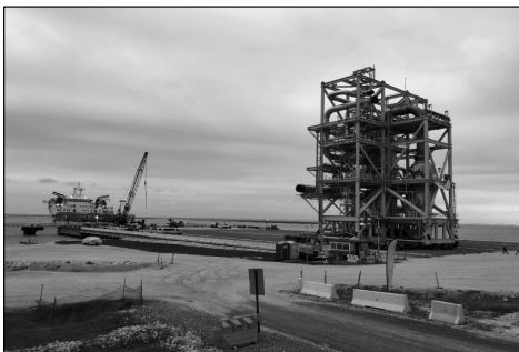
圖 7 模組滾裝上船後之情形（Ramp 已移除）
