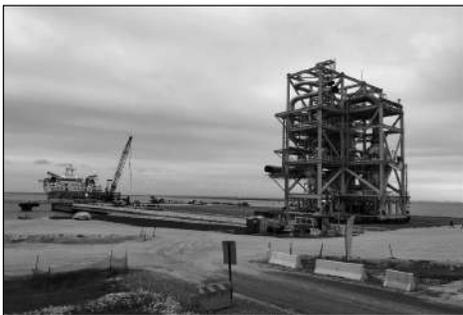
圖 7 模組滾裝上船後之情形（Ramp 已移除）
