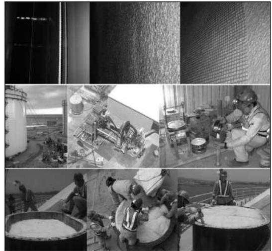
圖 35 內外槽夾層間保冷施工
