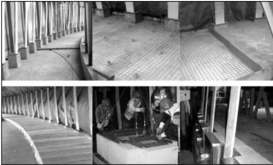
圖 23 底板環狀部保冷施工概況
