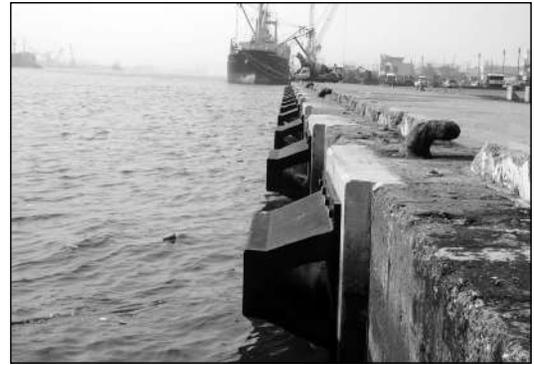
圖 12 岸邊之碰撞墊示意圖 (黑色部分)
