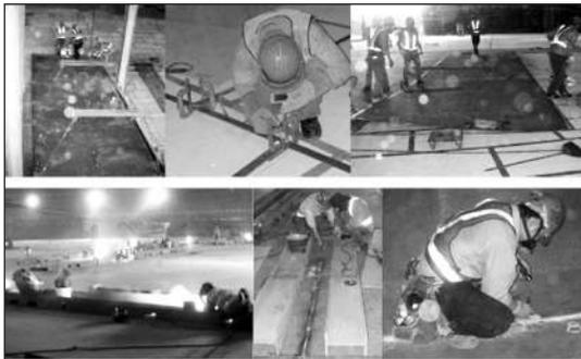
圖 27 內槽底板組立、銲接及檢驗
