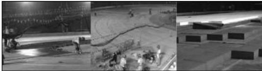
圖 26 底板中心部位保冷施工
