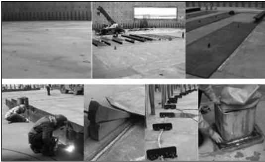
圖 17 底部襯板鋪設、銲接及檢驗
