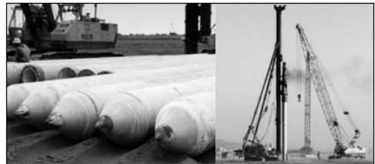
圖 6 基樁打設情形
